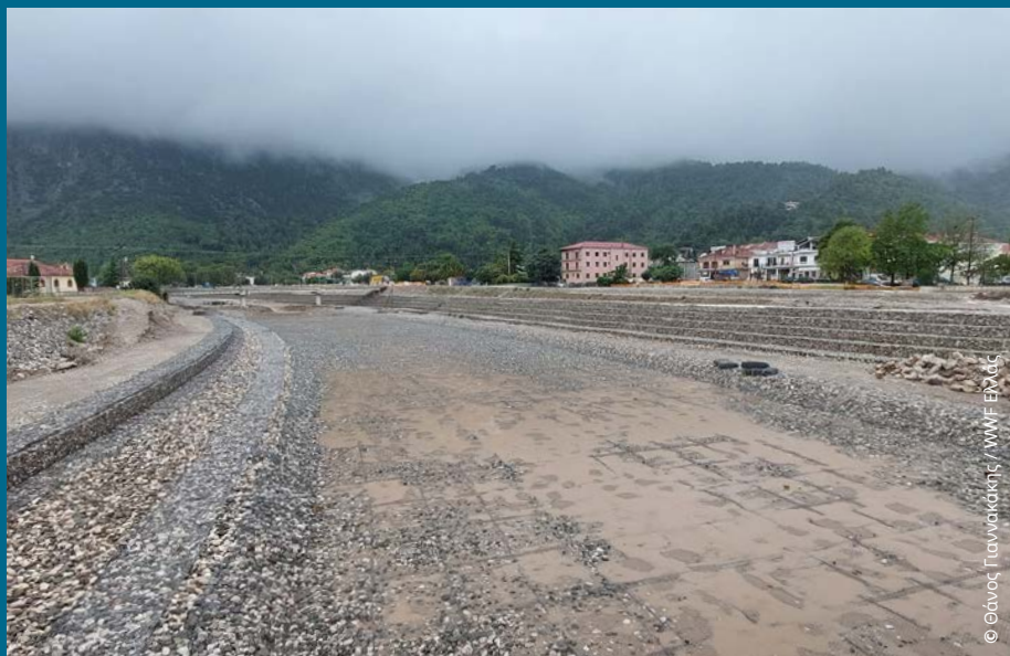
«Αντιπλημμυρικά έργα» στον π. Πάμισο, στο Μουζάκι, μετά τον Μεσογειακό Κυκλώνα Ιανό.
