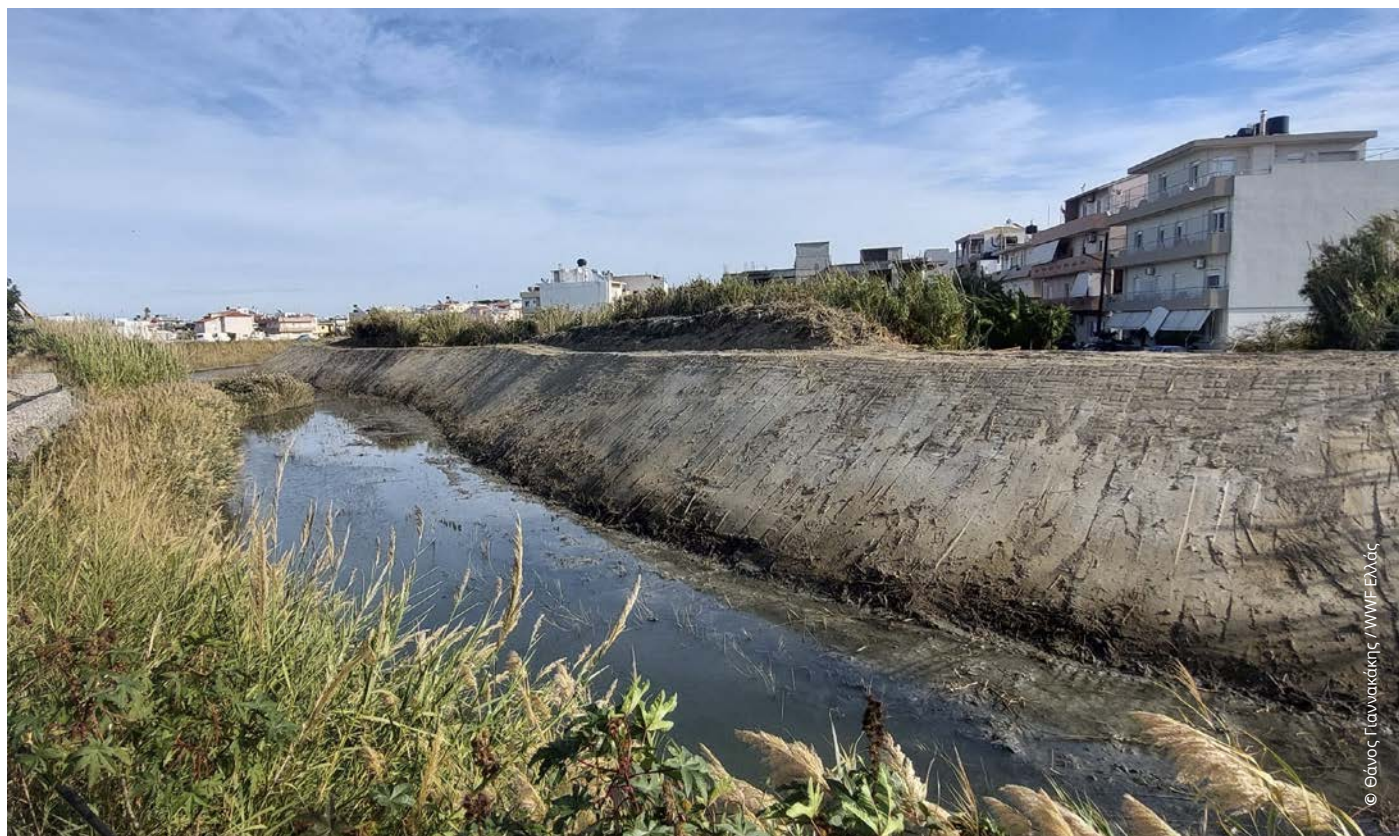
Μη επιλεκτική αραίωση της βλάστησης, στην κοίτη του ποταμού Γιόφυρου, στο Ηράκλειο Κρήτης
